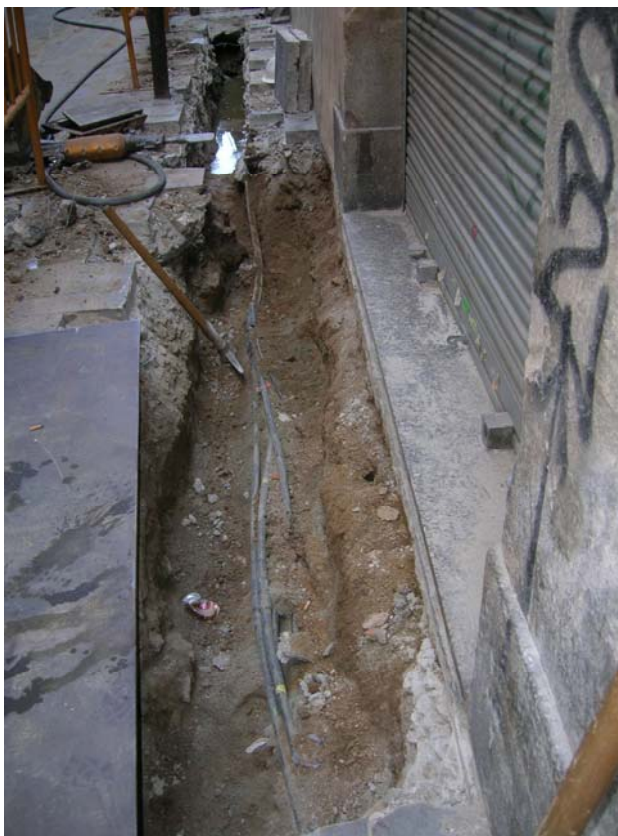
Foto 3: Tram rasa 100 C/ Cendra resseguint on s'observen altres línies elèctriques en funcionament.
