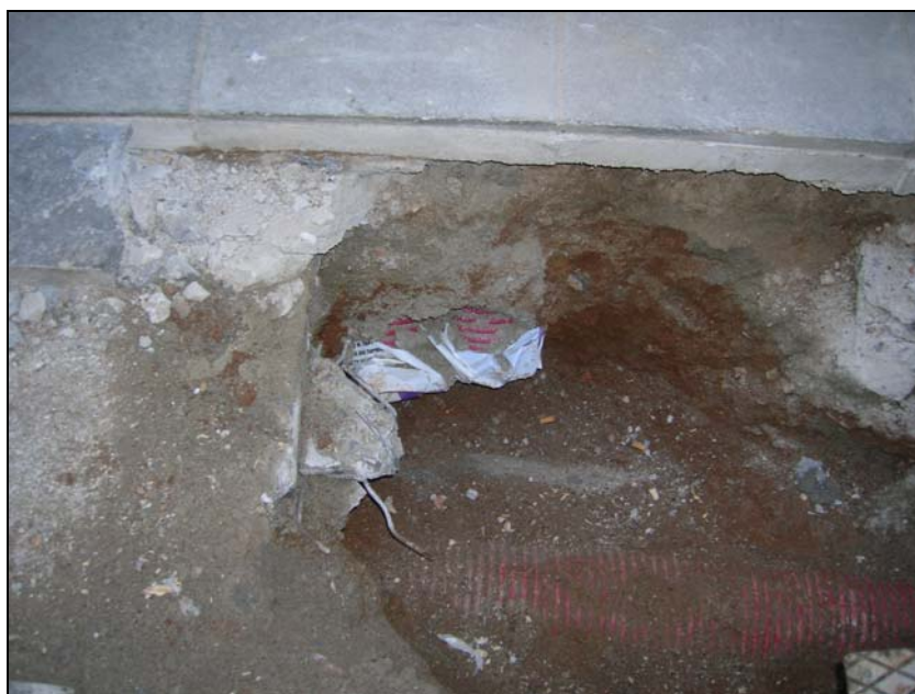
Foto 2: Sortida tubulars finca C7 Cendra 8b on es porta la nova línia elèctrica
