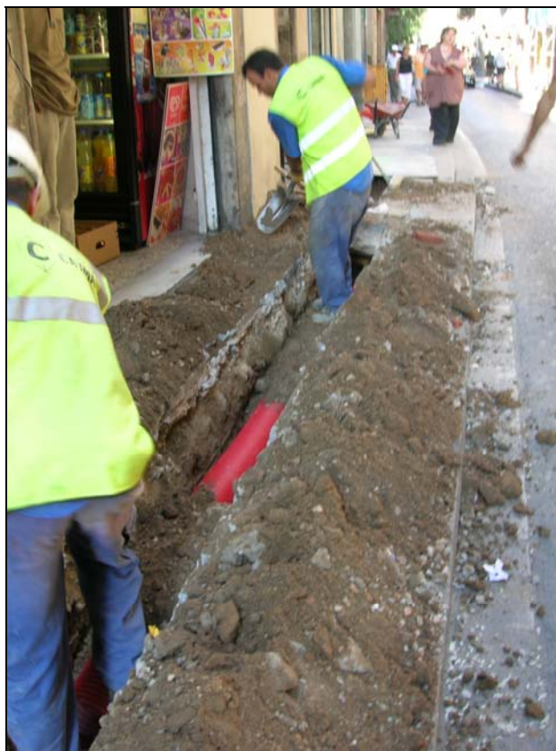
Foto 5: Col·locació tubulars rasa 100 tram St. Antoni Abat
